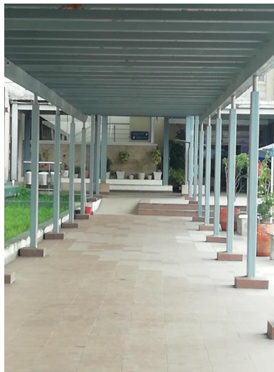
Ingreso Edificio 26 mediante rampa y escalones
