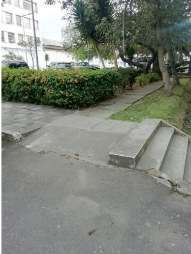
Acera lateral Facultad de Eléctrica y Electrónica
