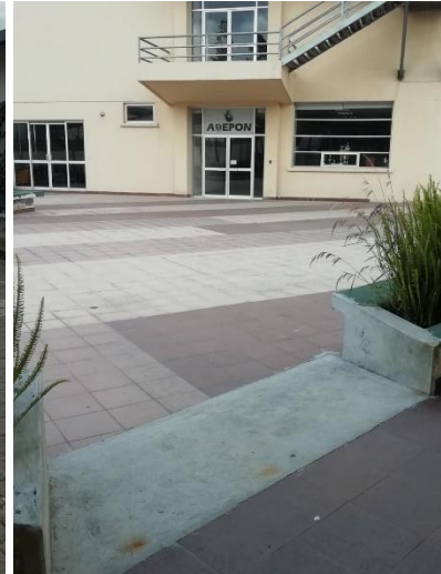
Ingreso lateral en edificio 25
